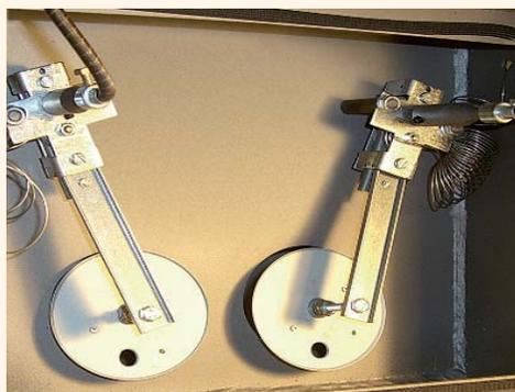
Die beiden Regler für die Primär- und Sekundärluft werden im Kaltbereich gesteuert und sind dadurch komplett wartungsfrei. Alles funktioniert gänzlich mechanisch und ohne Strom. Der Ofen holt sich die benötigte Menge Luft von allein.
